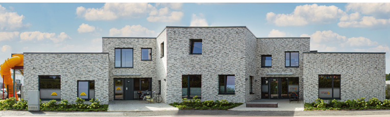
Movere-Gebäude an der Eschenallee 16, 59063 Hamm
