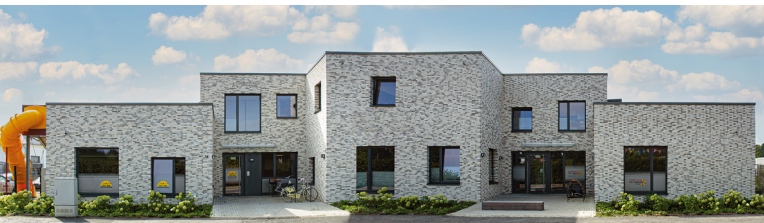
Movere-Gebäude an der Eschenallee 16, 59063 Hamm
